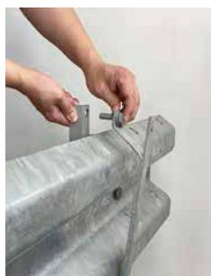
①金具でガードレールを挟み込みボルトで固定します
