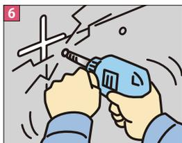
6 マーキングに合わせて、ドリルでアンカー取付け用孔を穿孔し粉塵を取り除きます。
