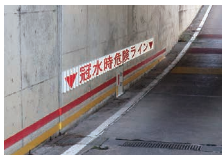
アンダーパス _ 左側 _ 注意喚起
