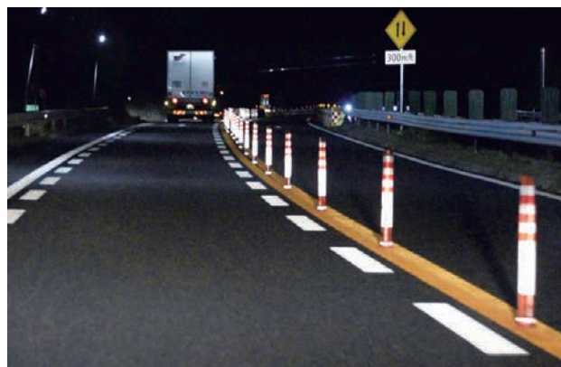
中央分離帯視線誘導
