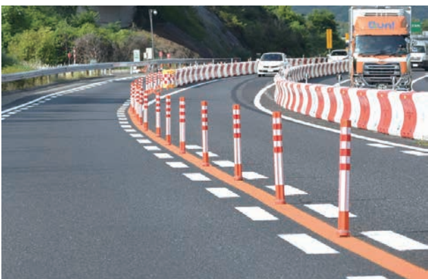
中央分離帯視線誘導
