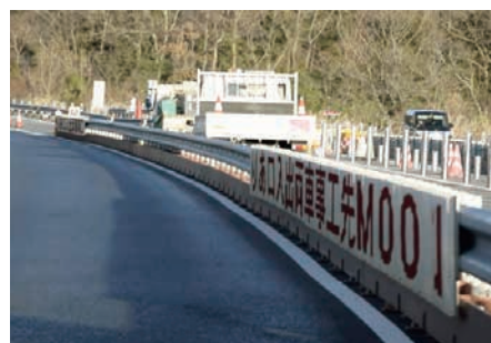
右側 _ ガードレール _ 注意喚起
