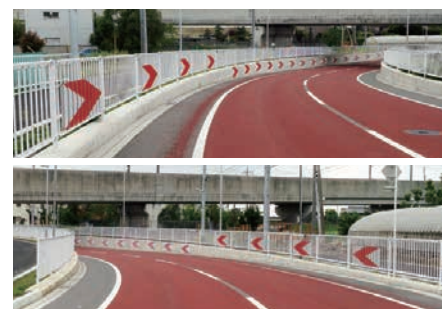
転落防止柵 _ 両面標示 _ 線形誘導
