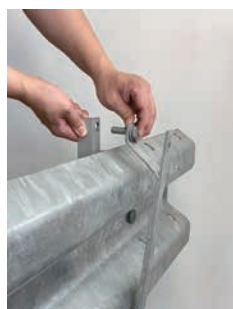
①金具でガードレールを挟み込みボルトで固定します
