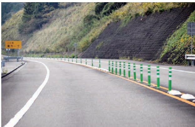
中央分離帯視線誘導
