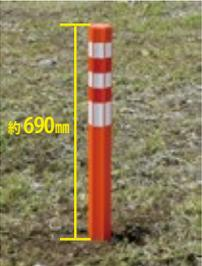
⑤ウェーブポスト固定後、穴を埋め戻して施工完了。(ウェーブポスト高さ：地表から約690mm)
