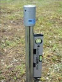
②打ち込み途中で数回、水準器で垂直を確認します。
