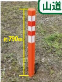
⑤施工完了(ウェーブポスト高さ：地表から約790mm)
