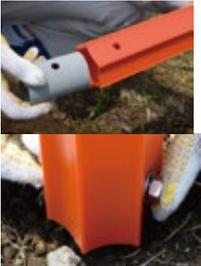
④ウェーブポスト内側に付属のスペーサーを入れ、金具(ボルト、ワッシャー、ナット)で固定します。
