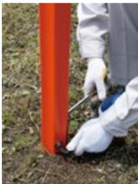
④ウェーブポストを被せ金具(ボルト、ワッシャー、ナット)で固定します。
